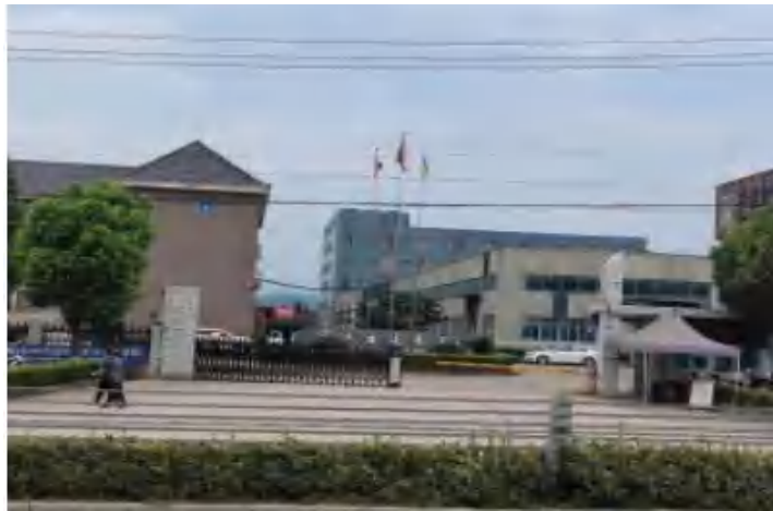
项目西面（宁波亚达电器有限公司）
