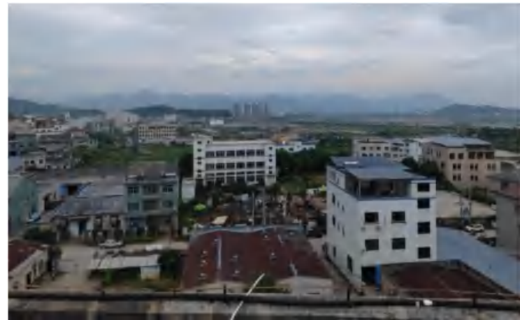
项目北面（宁海坤秀塑料电器厂、宁海县西店根木五金厂）
