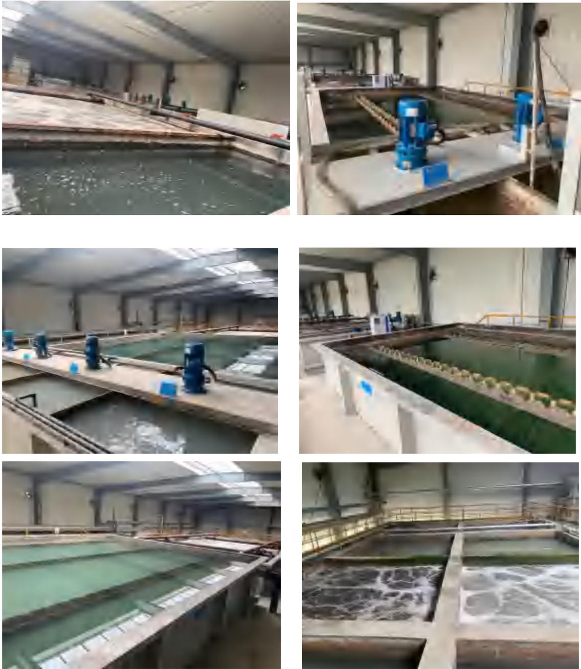
图 3-2 小件涂装综合废水、生活污水 1 废水处理设施图
