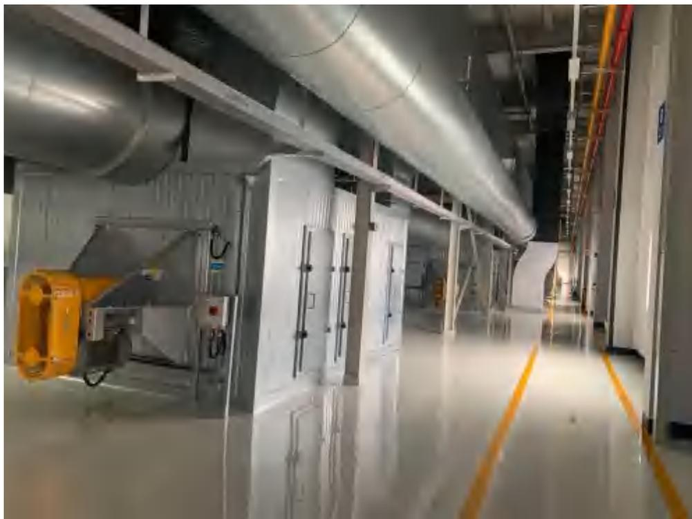
图3-18涂装二面漆烘干废气废气处理设施图
