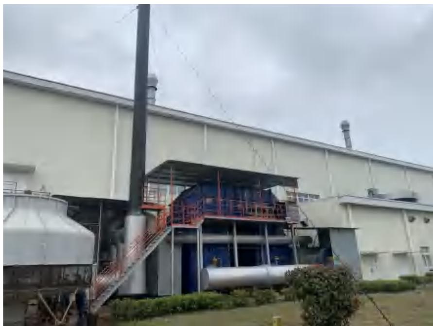
图3-20小件涂装喷漆废气、烘干废气废气处理设施图
