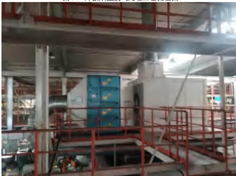
图 3-10 焊接烟尘废气处理设施图
