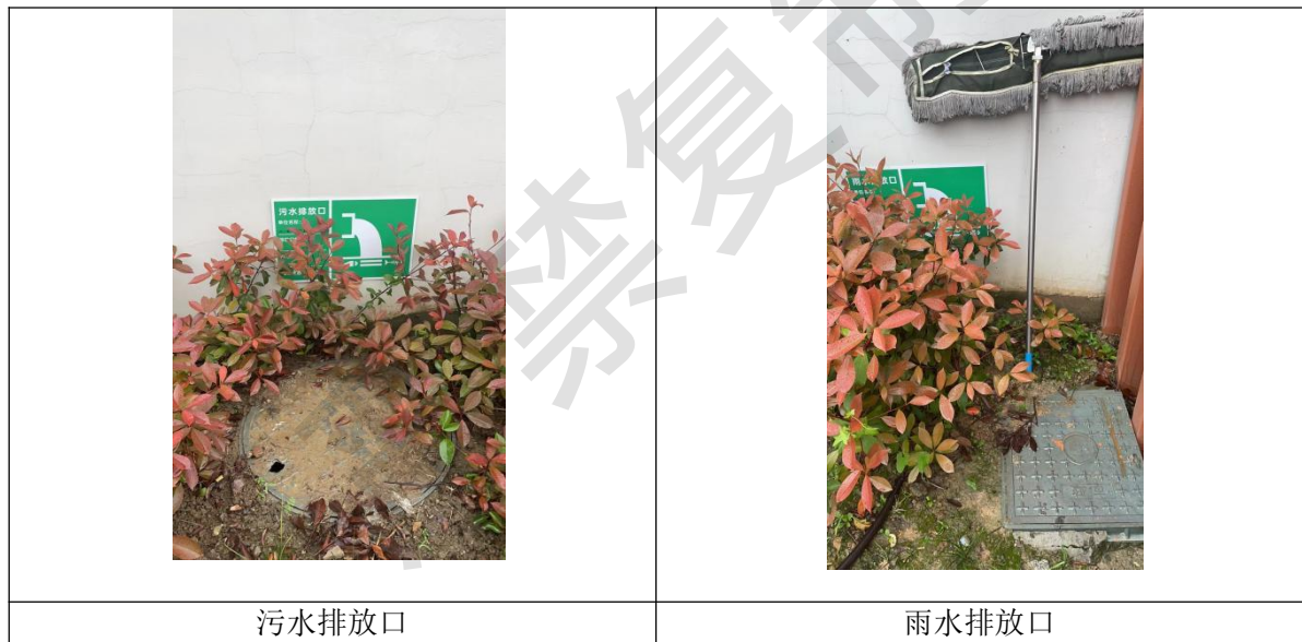
图 3-4 雨排口现场图
