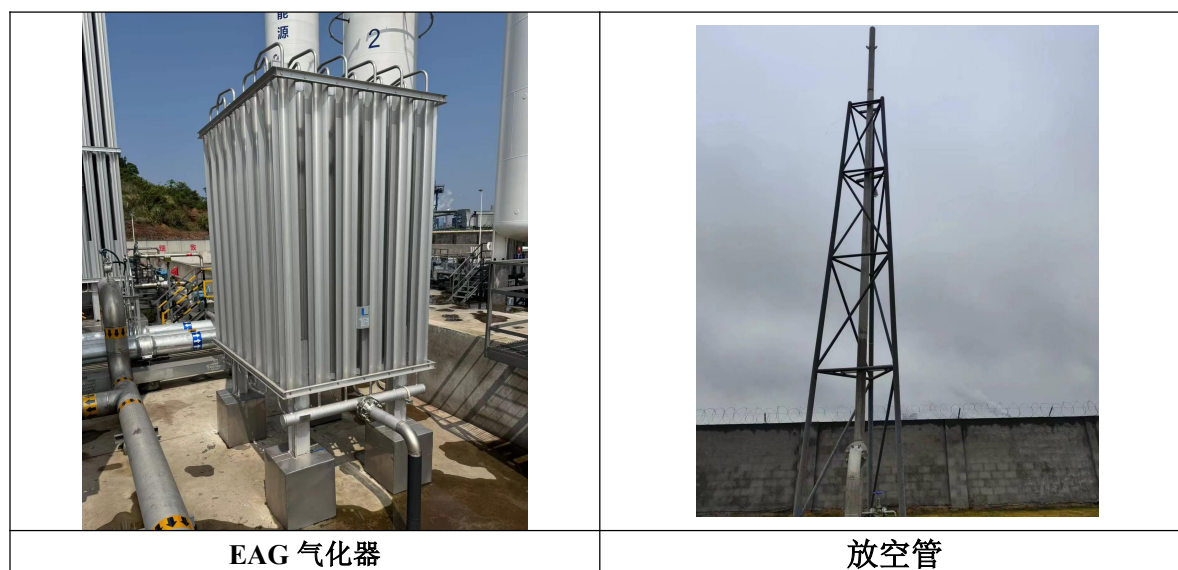
图 3.2-3 废气处理设施图
